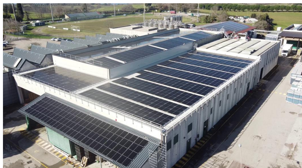
Impianto FTV e nuova copertura
